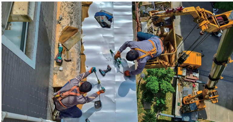
4月18日,江苏南通崇川区某小区。该小区是老旧小区,一些住户的雨棚因年久失修,有的已破败不堪。为避免安全隐患,工作人员趁着晴好天气,通过大型吊车为住户维修雨棚。
